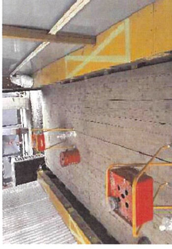
休憩所の壁を一部撤去し、通気性を確保
