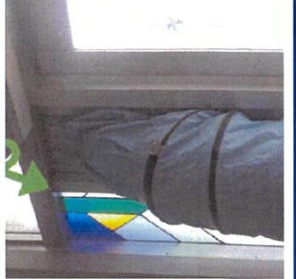
内装工事において、送風機及び冷却器を使った換気を実施
