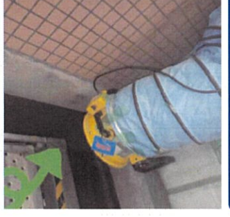
内装工事において、送風機及び冷却器を使った換気を実施
